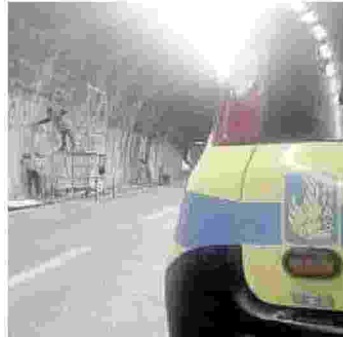
Manutenzione di una galleria
