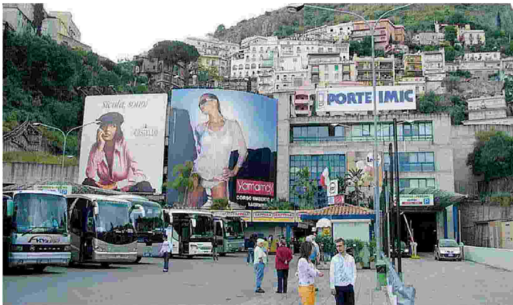
La sede dell'Azienda Servizi Municipalizzata. Gli uffici dell'Asm si trovano nell'edificio del parcheggio Lumbi
