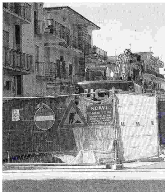
Lavori in corso in via Martiri d'Ungheria per le fogne. I commercianti puntano a sospendere gli interventi per le feste di Natale
