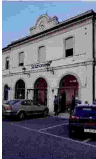
La stazione di Cittadella
